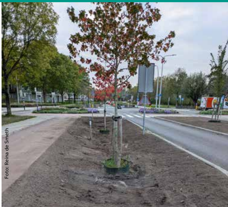
onder: Aanleg wadi, Voorschoten
