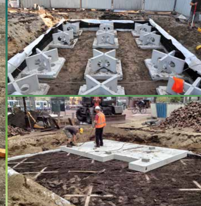
De Treebox HP groeiplaatsconstructie op het Haarlemmerplein in Amsterdam
