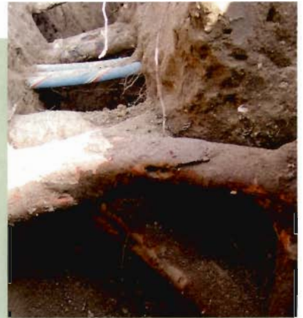
Electriciteit, telefoon en vochttransport voor de boom lopen allemaal kris-kras door elkaar (boven). Foto op de linker pagina laat het resultaat zien van de veranderingen van de oude situatie (onder).
