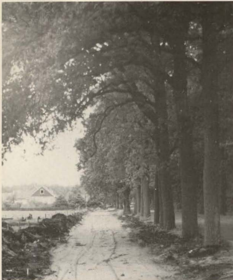
Door de aanleg van een fietspad in de berm kan de vitaliteit van de bomen sterk verminderen. Dit kan tot gevolg hebben dat er wijzigingen in het snoei-beleid zullen ontstaan.
