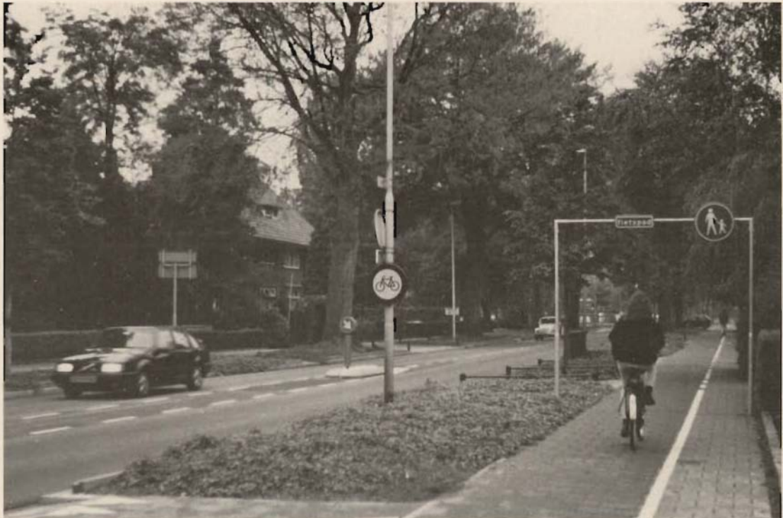
Veel graafwerk voor de wegreconstructie en de aanleg van het fietspad in de wortelzone van de oude beuken heeft de bomen geen goed gedaan
