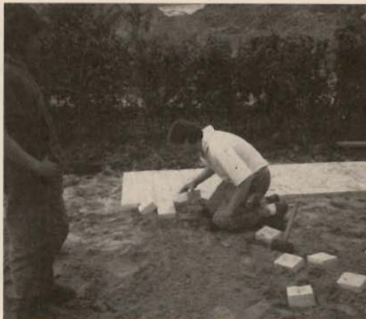
Begin juni werd door leerlingen van de Leidse L.T.S. begonnen met het leggen van de bestrating. foto: Frank Moens
